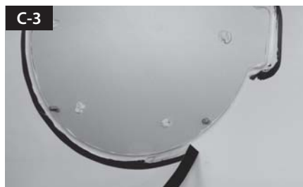
Verwijder de wrijvingstape en laat drogen
