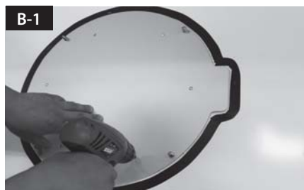
Plaats de bevestigingsplaat terug op de aangebrachte siliconenkit en maak 6 gaten (2mm) met de boor
