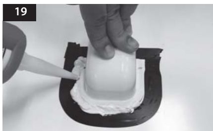
19 Breng siliconenkit aan rondom de kabelhouder.
