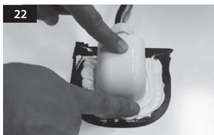
22 Snygga till tätningsmassan.
