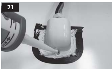
21 Lägg tätningsmassa runt och ovanpå skruvarna.
