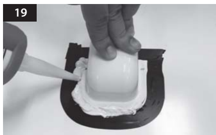
19 Applicera tätningsmassa runt kabelhuset.
