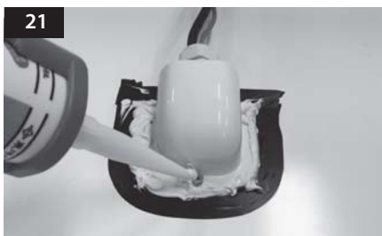
21 Breng siliconenkit aan op en rondom de schroeven.
