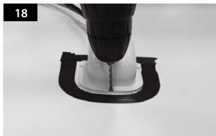
Platzieren Sie den Kabelhalter auf der mit Isolierband markierten Fläche und bohren Sie 3 2mm Löcher.
