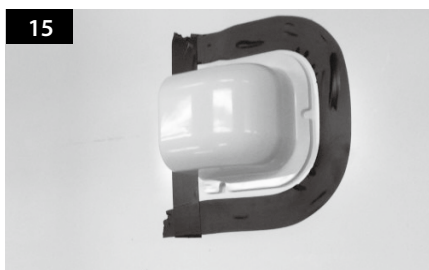
Positionieren Sie den Kabelhalter mittig vor der Antenne (30cm entfernt). Die offene Seite des Kabelhalters soll Richtung Befestigungsplatte zeigen. Danach kleben Sie das Isolierband um den Kabelhalter herum.
